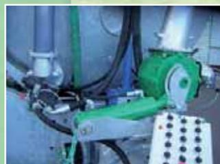
▲ Vanne de réglage de débit en sortie de turbine
