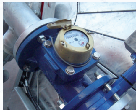
Compteur d'eau bridé sur entrée bobine.
